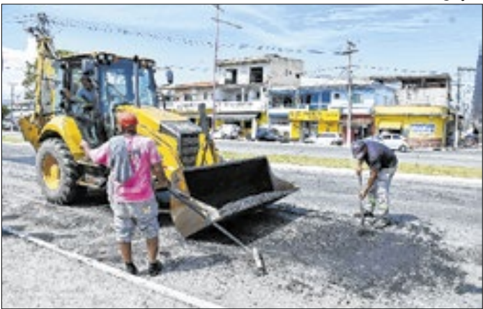
Mais de 50 toneladas de massa asfáltica foram aplicadas
