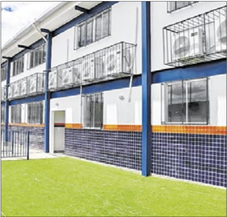
Aparelhos de ar-condicionado estão chegando às escolas
