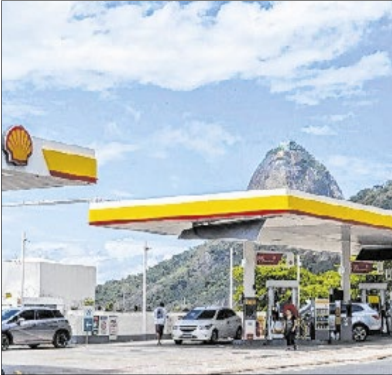
Posto de combustíveis da Raízen no Rio de Janeiro
