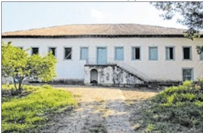
Área abriga a construção que tem cerca de 200 anos
