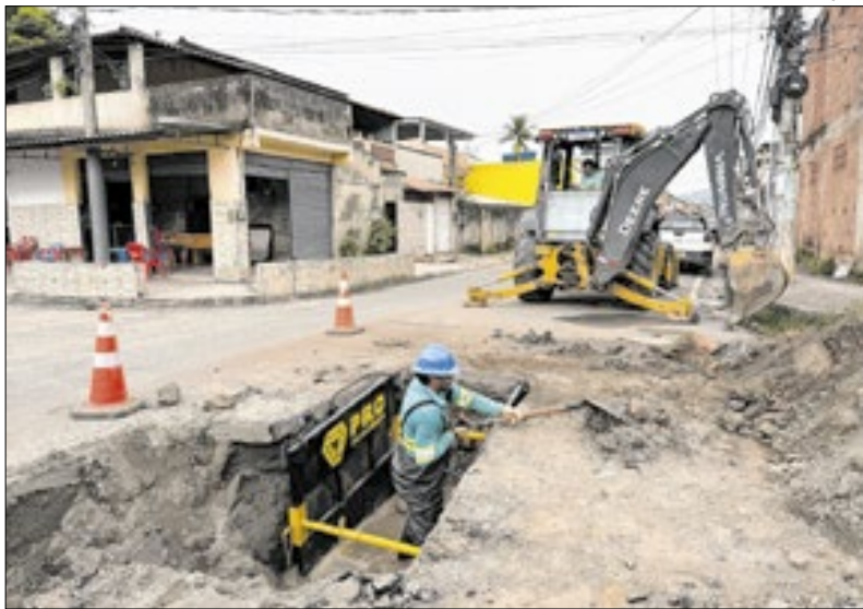
Bairro São Francisco de Assis teve implantação de 20 km de rede de abastecimento
