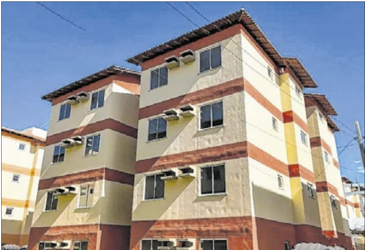
Prédios fazem parte de um conjunto de obras que estavam paradas
