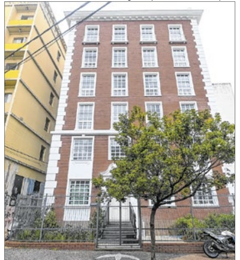
Edifício no Largo das Andorinhas está com obras em andamento
