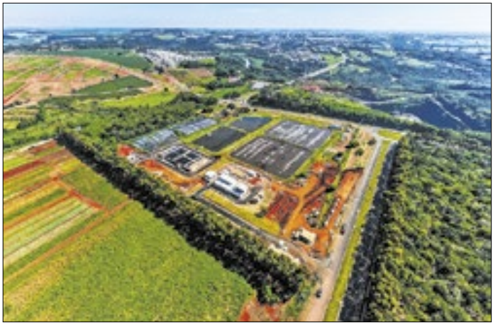
O investimento moderniza o sistema de esgoto da cidade
