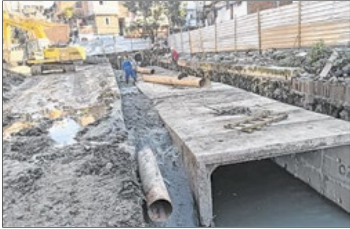
Instalação da rede de esgoto na comunidade da Z.S.
