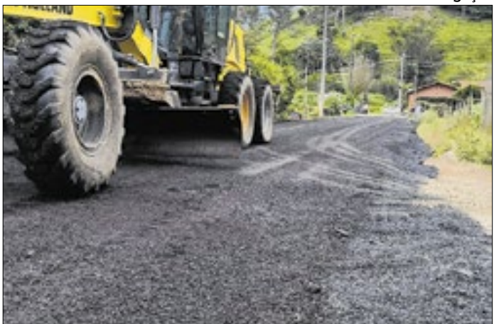
Obras no 3º Distrito prevê pavimentação de cerca de 11 km
