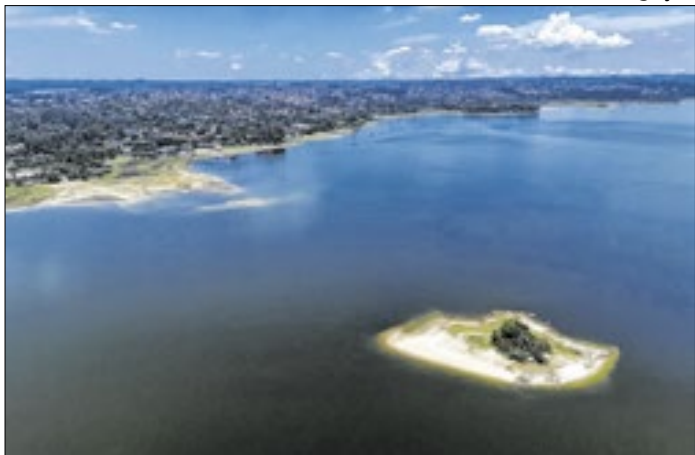
Captação de água feita na represa Guarapiranga
