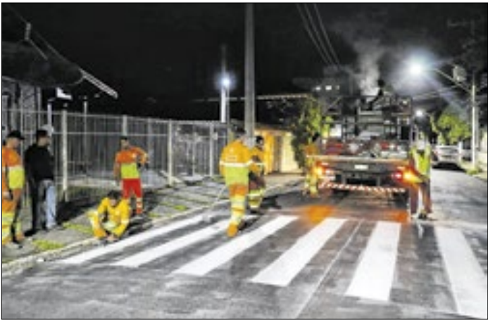
A sinalização é realizada nas vias que terão novo asfalto
