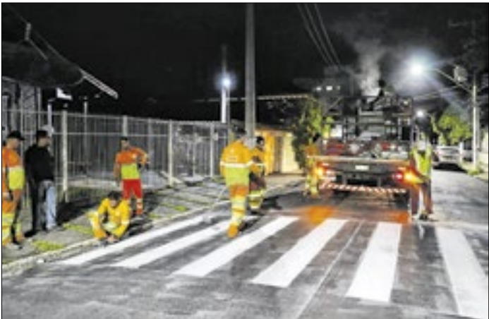
A sinalização é realizada nas vias que terão novo asfalto
