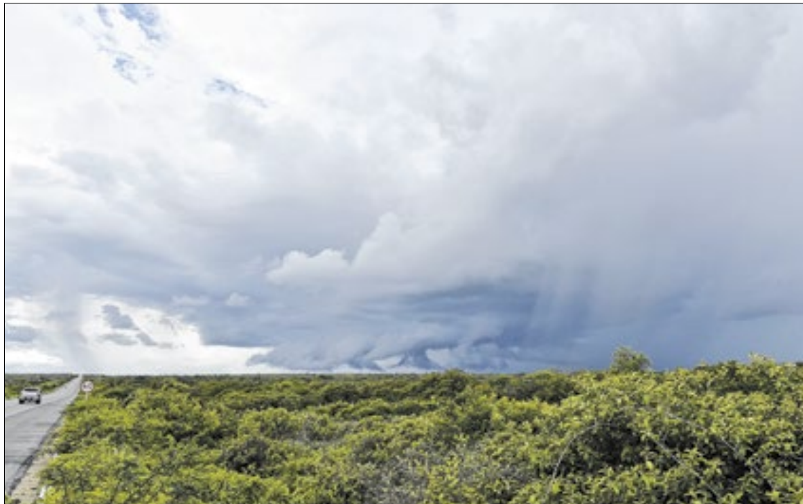
A barragem Dinamarca atingiu 100% da capacidade e começou a transbordar
