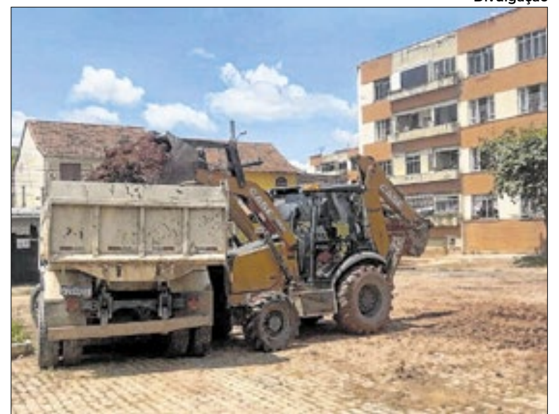
Além da troca das manilhas, a intervenção contempla a regularização da base
