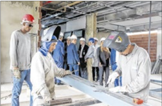
Novo complexo entrou na fase acabamento
