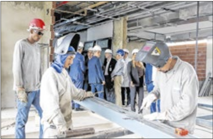
Novo complexo entrou na fase acabamento
