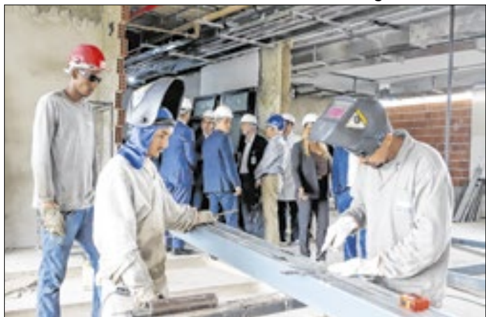
Novo complexo entrou na fase acabamento
