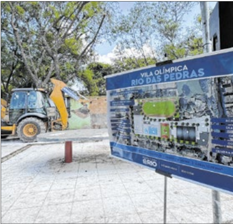
Equipamento ocupará uma área de 18 mil metros quadrados
