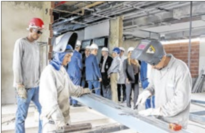
Novo complexo entrou na fase acabamento
