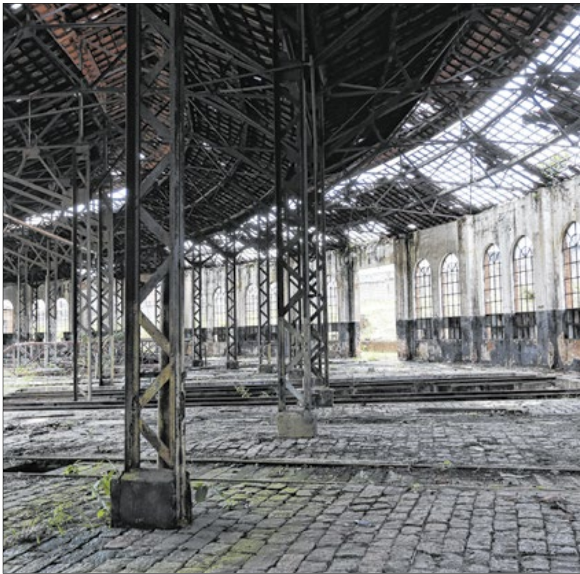
Estação do Trem Intercidades em Campinas será construída no Pátio Ferroviário da cidade
