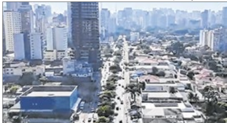
Região da Avenida Rebouças passará por obras do Metrô
