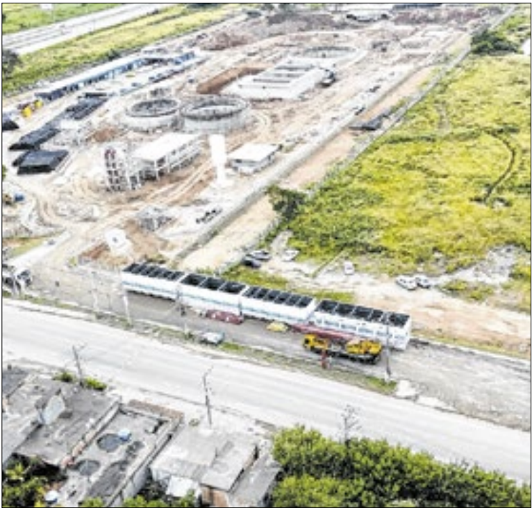
Obra ampliará a oferta em 9 milhões de litros de água por dia
