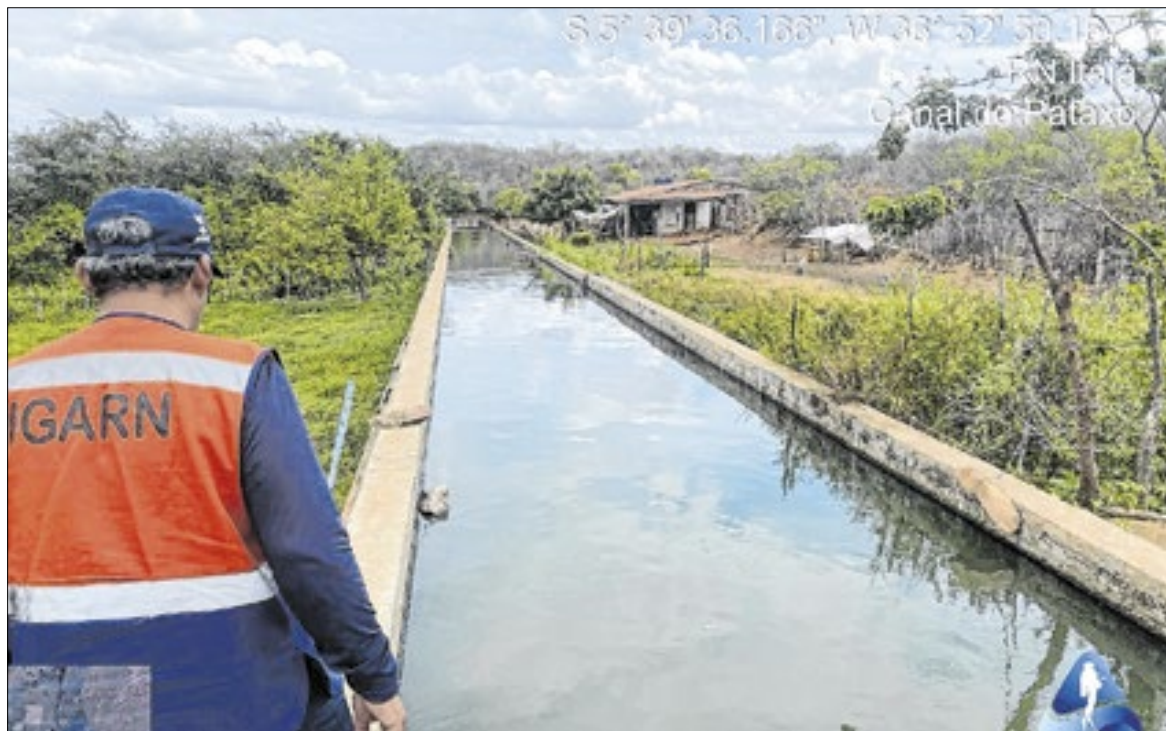
O canal recebe águas da Barragem Armando Ribeiro Gonçalves
