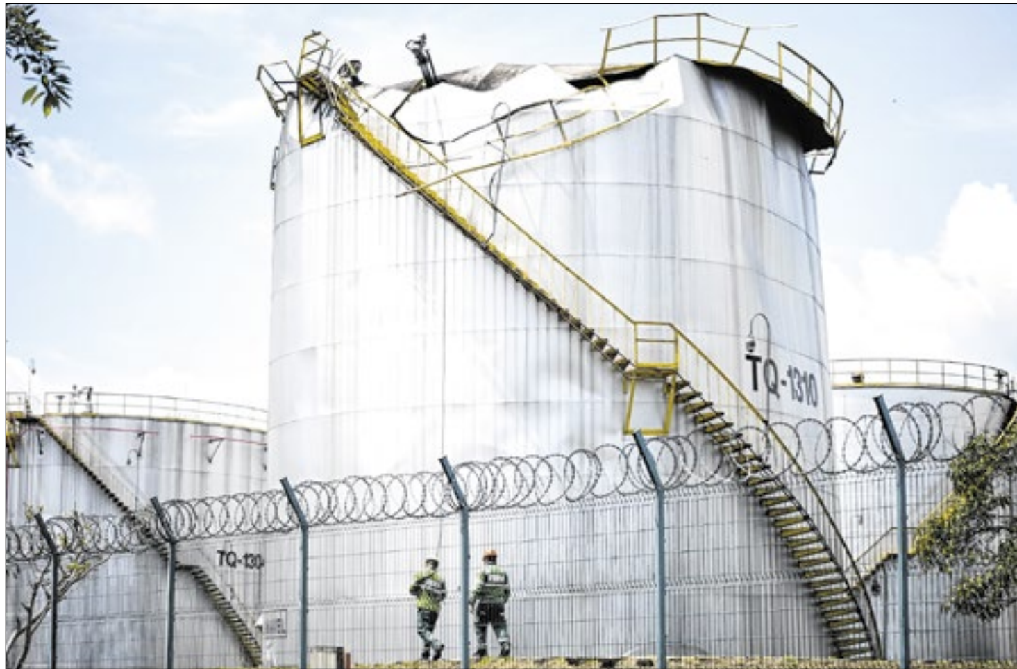
Acidente ocorreu durante uma manutenção com solda no tanque de combustível da Vibra
