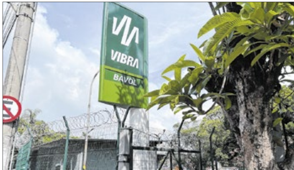
Base da Vibra em Volta Redonda-RJ onde teve explosão seguida de incêndio
