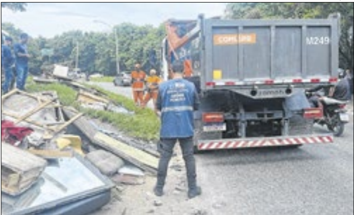
Estruturas de casas foram desmontadas durante a ação
