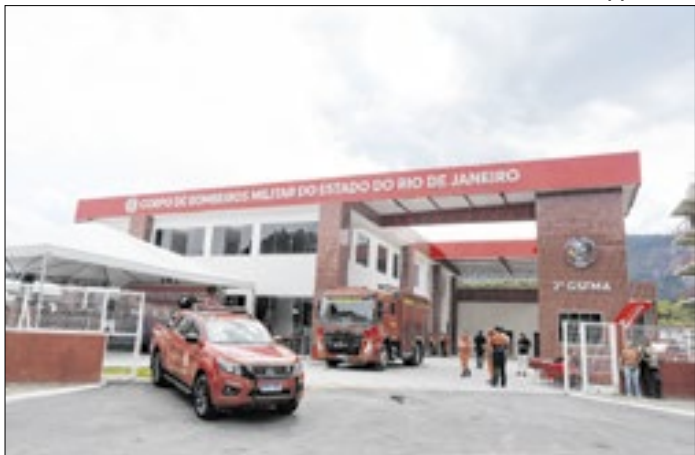
Unidade é especializada em incêndios florestais e resgates
