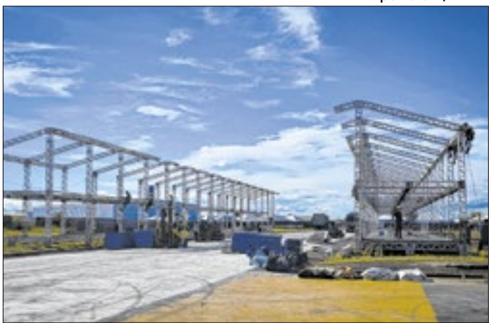
Estruturas são preparadas para os desfiles de Carnaval
