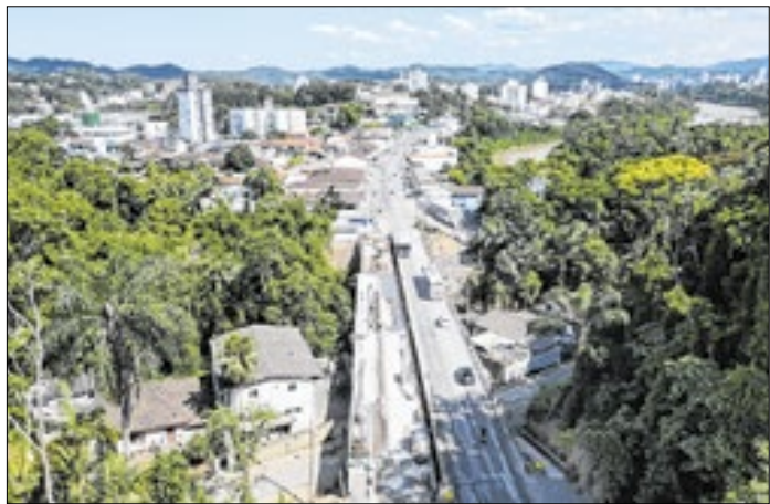
Obra altera seis linhas e pode se estender até terça
