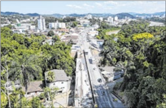
Obra altera seis linhas e pode se estender até terça
