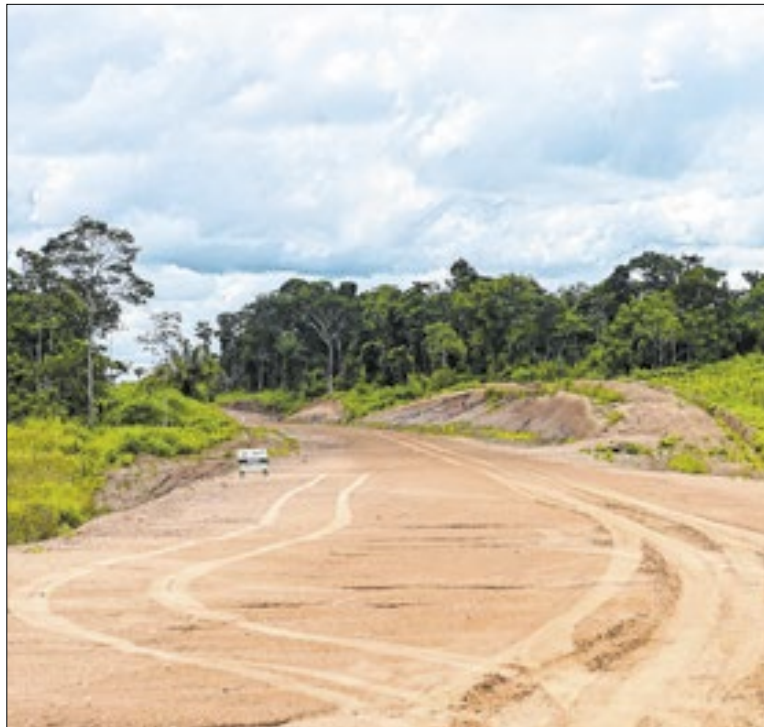
Obras abrirão novo acesso cruzando o rio Acre
