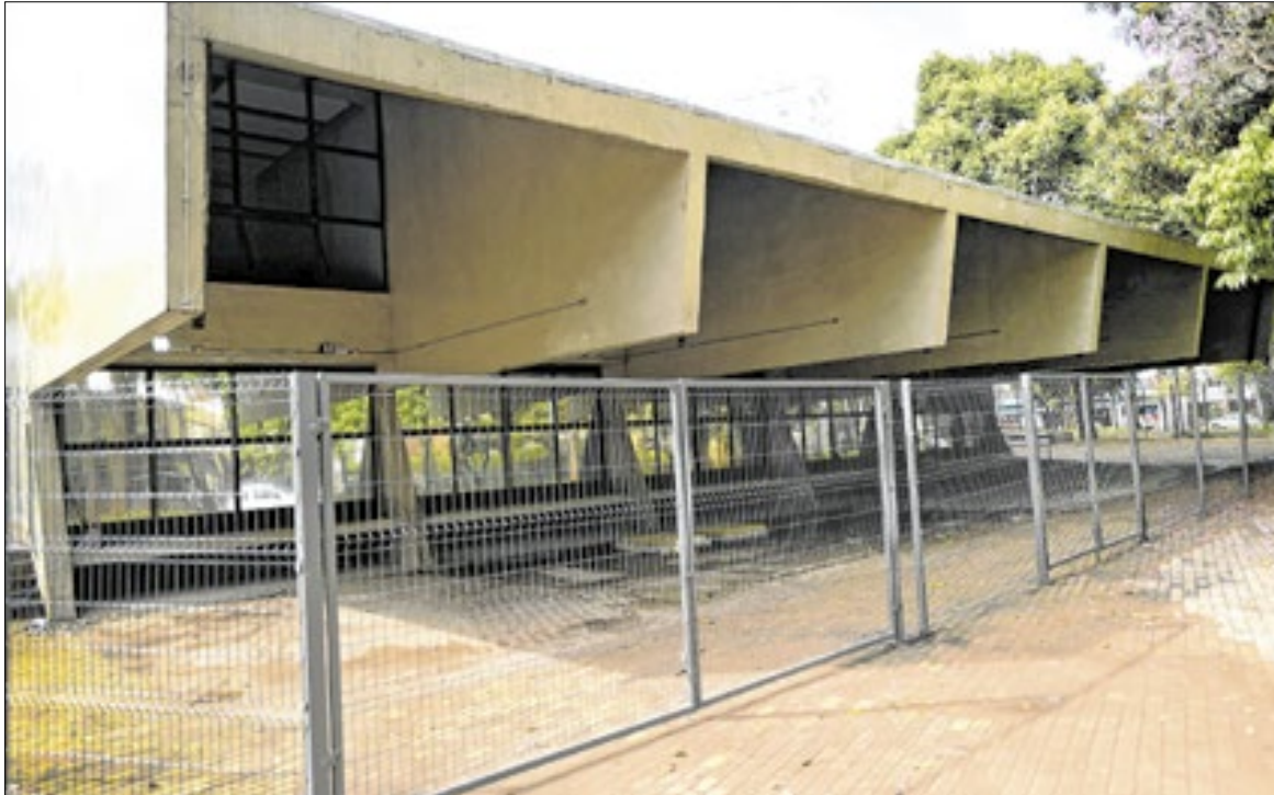
A instalação de gradis no entorno do Centro de Convivência Cultural (CCC), em Campinas
