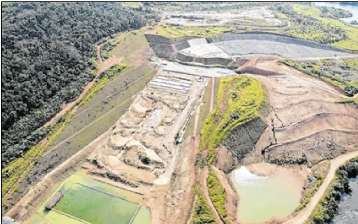
Construção de barragens de Pedreira e Duas Pontes foram retomadas
