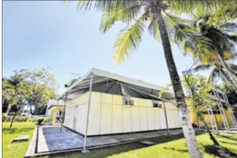
Governo acelera a montagem e instalação de tendas
