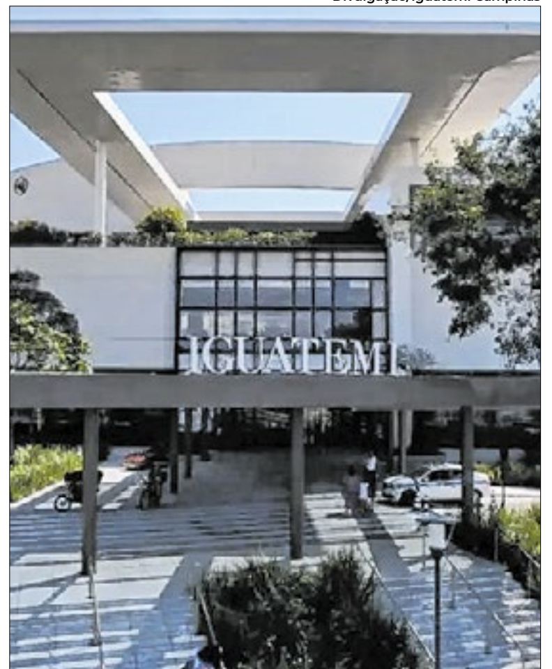
Shopping Iguatemi: corte de 78 árvores sem autorização
