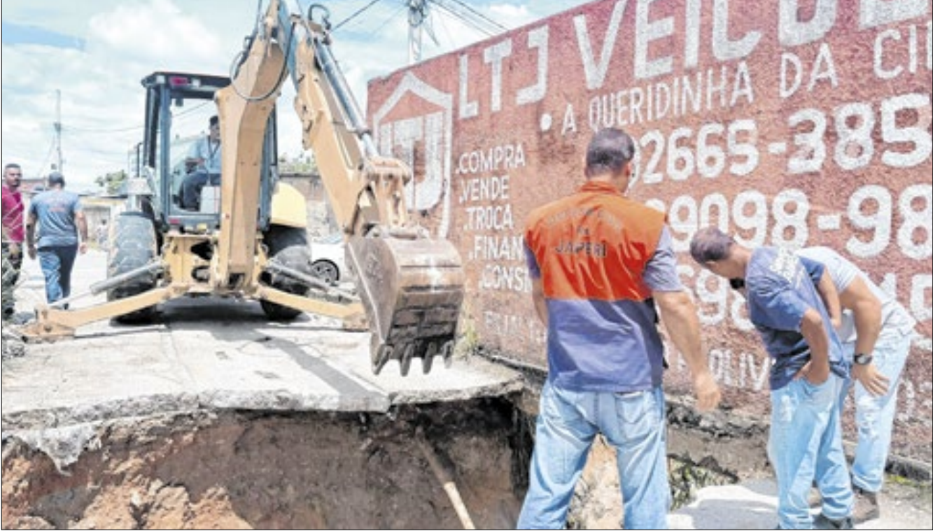
Serviços de desobstrução e retirada de barro seguem em diversos bairros, com plantão 24h da Defesa Civil
