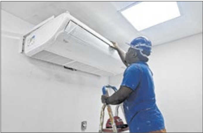
Instalação dos aparelhos de ar-condicionado avança
