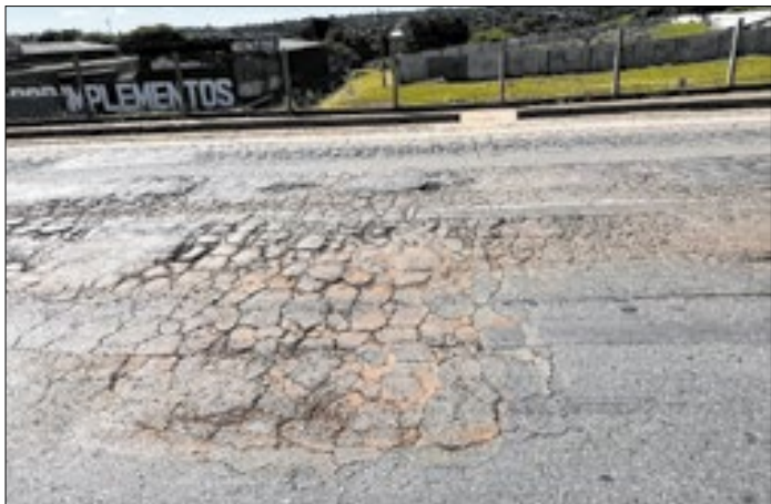
Desgaste ou Desagregação (nível severo) da EPNB
