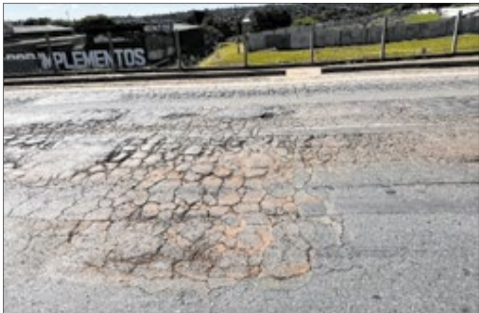
Desgaste ou Desagregação (nível severo) da EPNB
