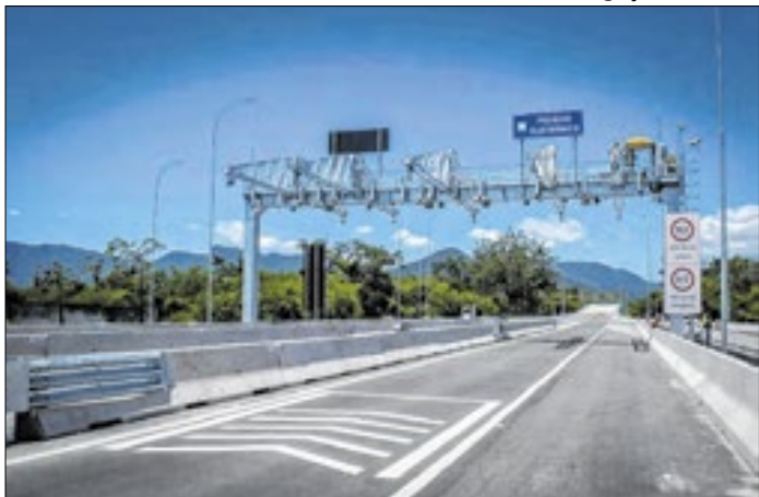
Foco é a instalação de pórticos no modelo free flow
