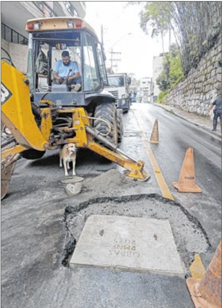
Algumas das ações: substituição de manilhas e redes pluviais
