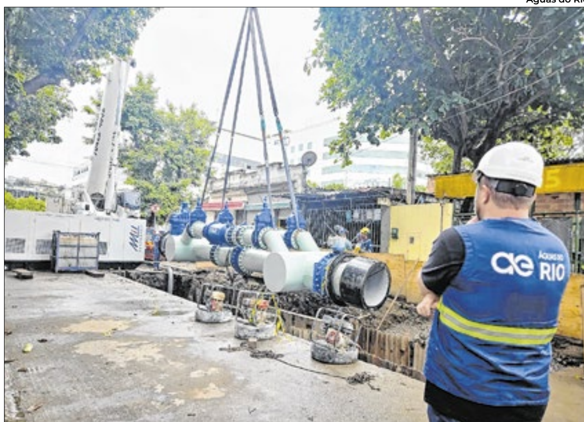
A instalação de sistemas de bombeamento tem sido decisiva para levar água com pressão adequada a regiões elevadas e às extremidades da rede
