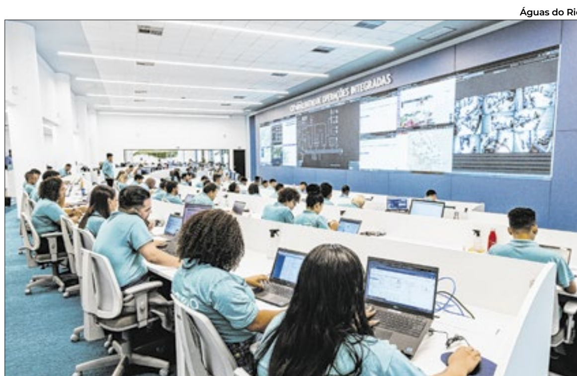
O Centro de Operações Integradas acompanha em tempo real a produção, a distribuição de água, o tratamento de esgoto e os indicadores de qualidade
