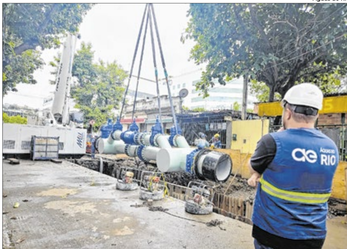
A instalação de sistemas de bombeamento tem sido decisiva para levar água com pressão adequada a regiões elevadas e às extremidades da rede
