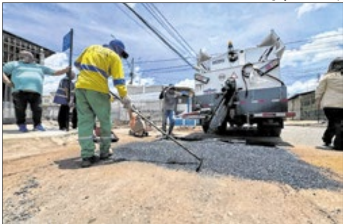
A massa asfáltica sai da usina a cerca de 170 °C
