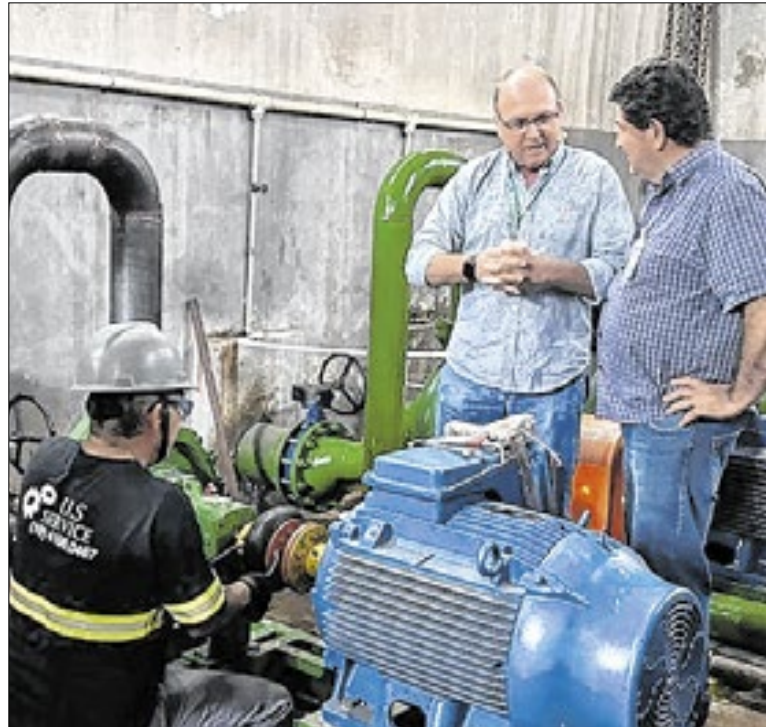
Técnicos do DAE instalam o novo conjunto motobomba
