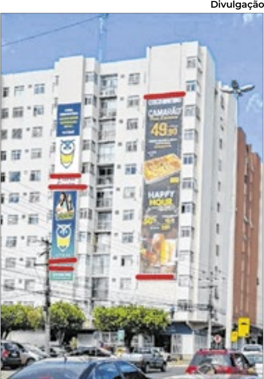
Edifícios em Águas Claras com outdoors gigantescos
