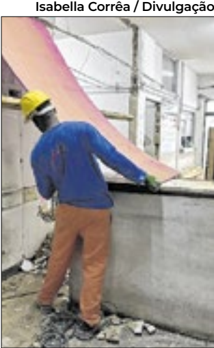
Reconstrução de estruturas
