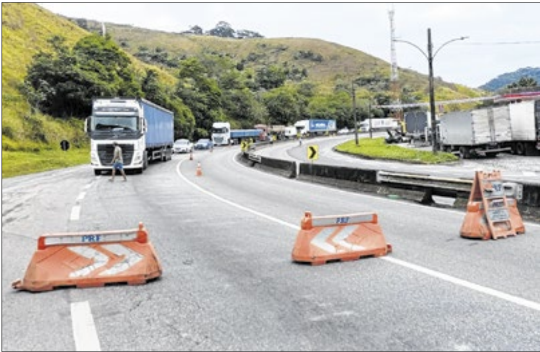
Arquivo/PRF A pista de subida da Serra das Araras ficará bloqueada para desmonte de rochas na quarta
