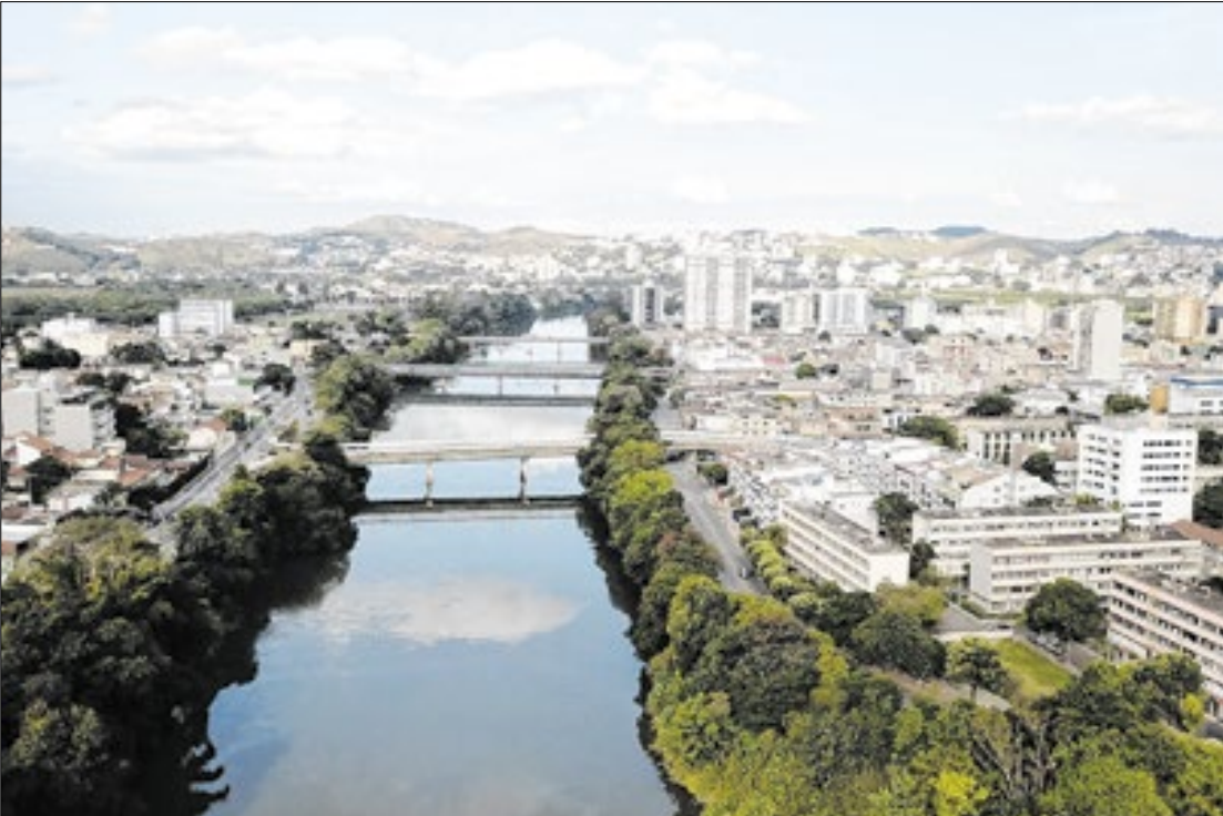
Cidade de Volta Redonda, no interior do Estado do Rio, terá uma estação do trem-bala
