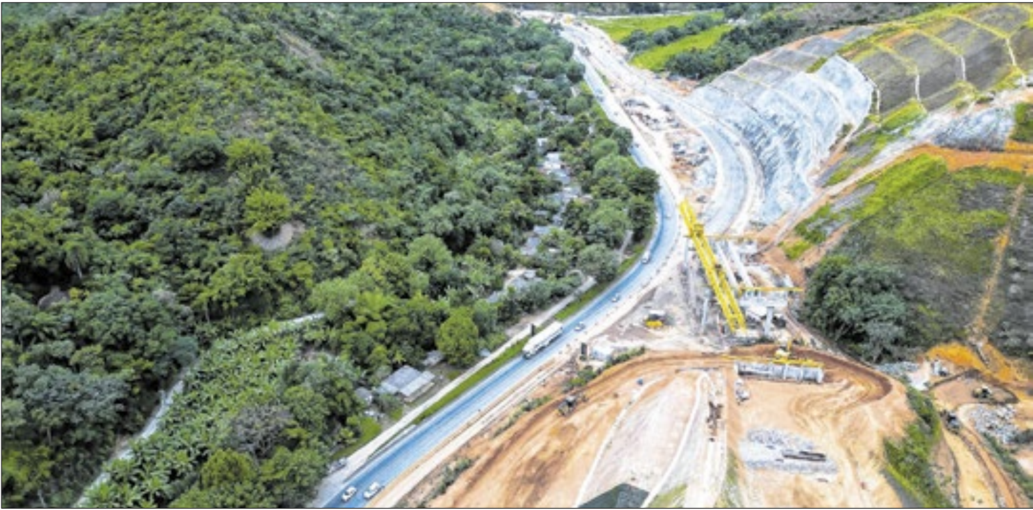
Obras de duplicação, que devem terminar em 2027, vão dar fim as curvas sinuosas do trecho
